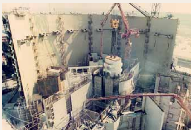
Монтаж на корпуса на реактора, април 1985 г.
