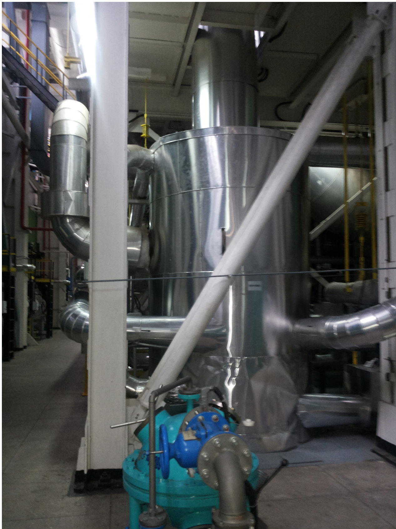
Фиг. 3 Външен вид на строителната конструкция и разширител 5SH10B01
