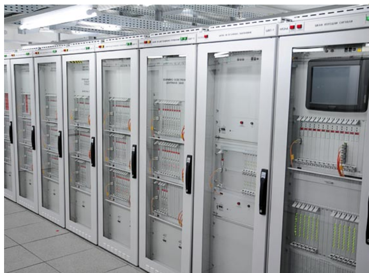
Трета управляваща система за безопасност на пети блок – панели за управление
