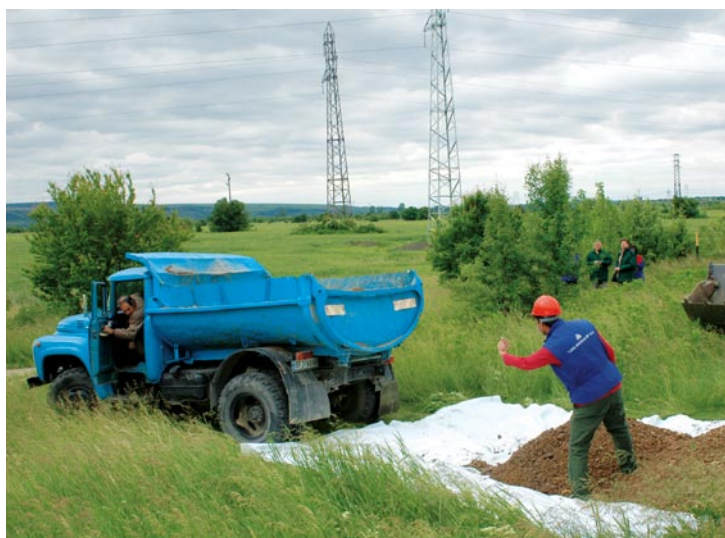
"Отстраняване на локален теч" от дига чрез покриване на мястото с платно от геотекстил и баластра
