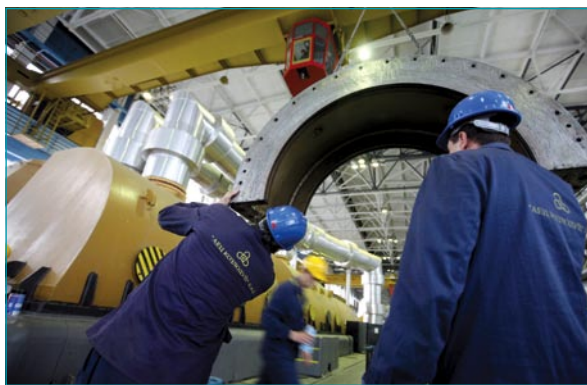
Машинната зала на 3 и 4 блок, 23 януари 2009 г. Снимка: Петър Петров
