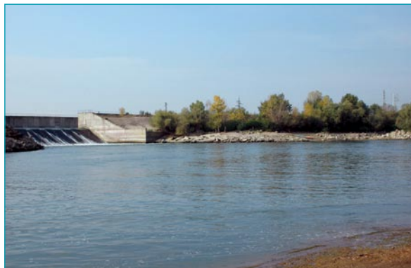
Заустване на Топъл канал 1 в река Дунав
