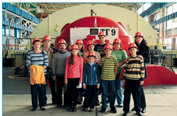
В машинната зала на пети блок
