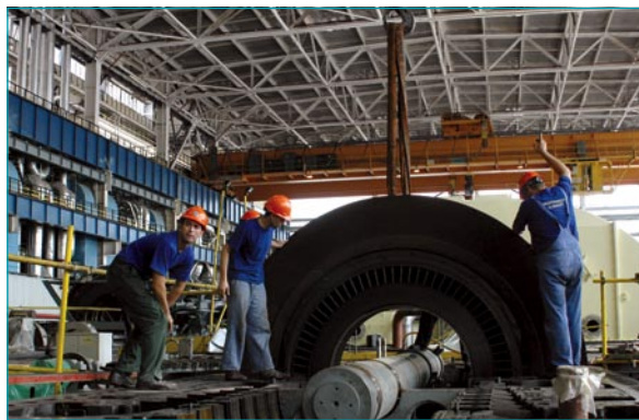
Ремонт на 10-ти турбогенератор на 6 блок
