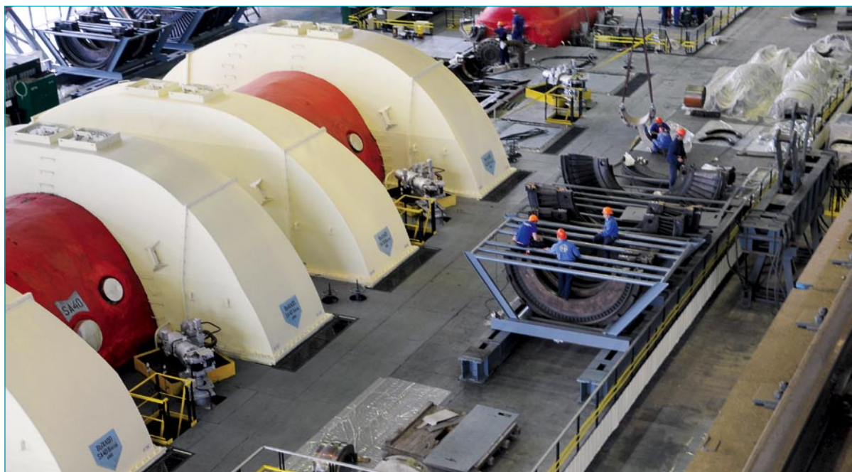
Ремонтни дейности в машинната зала на 5 блок
