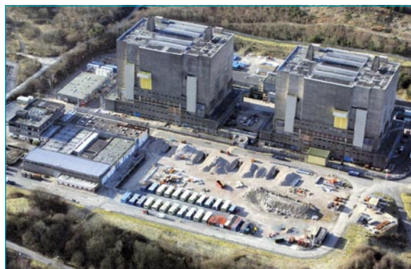
Площадката на АЕЦ "Троусфинид"
