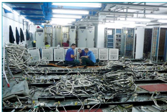
Демонтаж на старата аналогова първа система за безопасност на 6 блок
