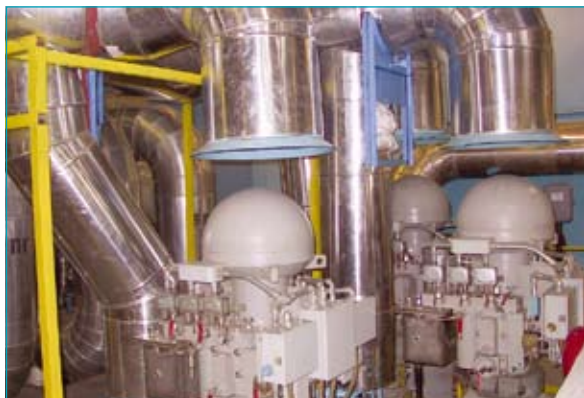
Бързодействащи отсичащи клапани (БЗОК) на паропроводите на парогенераторите на 3 и 4 блок
