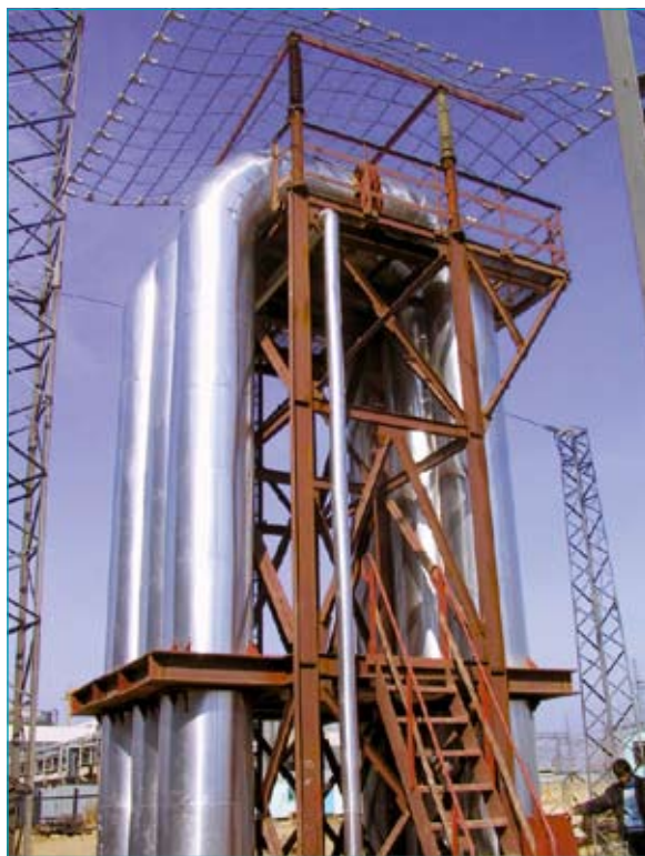
Хидрозатвори на система за техническа вода – група "А" на 3 и 4 блок
