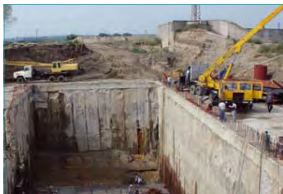
Фундаментът на бъдещата ВЕЦ е под нивото на река Дунав
