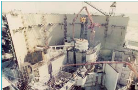
Операции по монтаж на корпуса на реактора в реакторно отделение, 11 април 1985 г.
