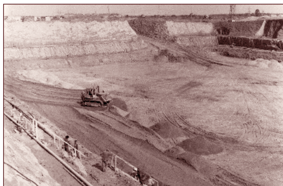
Котлованът на пети енергоблок през лятото на 1980 г.
