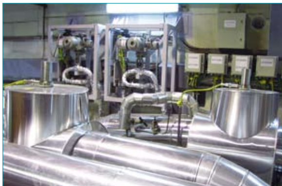
Нови прегпазни клапани на парогенераторите
