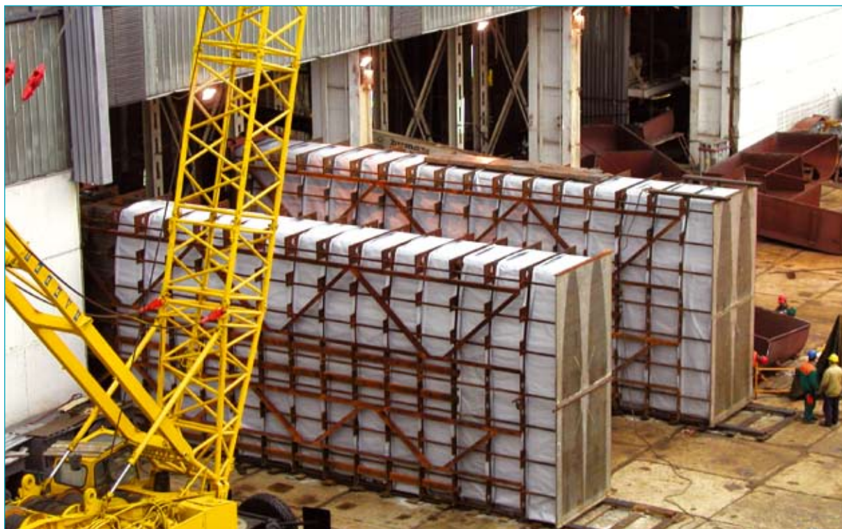
Подмяна на тръбните снопове на кондензаторите – една от най-мащабните мерки от Програмата за модернизация, 2004 г.
