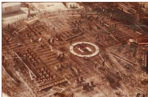
Бетониране на кота 13,20 на реакторно отделение, 15 март 1984 г.
