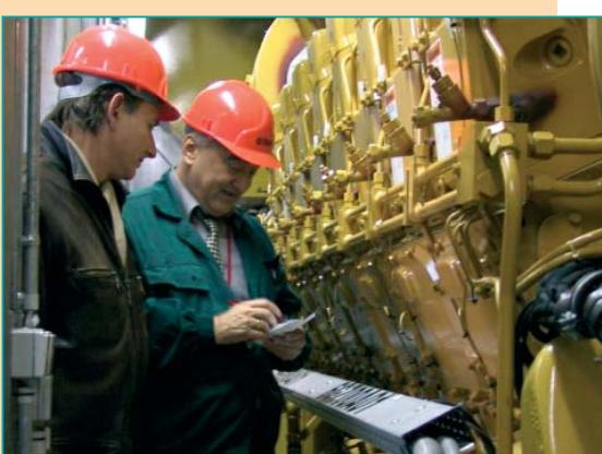
**Е**дна от големите модернизации, приключила по време на ПГР 2003, е изграждането на допълнителен дизелгенератор. Съоръжението е предназначено да съхранява ресурса на оборудването в аварийни режими, като осигурява щадяща срока за работа на системите в случай на обезточване на блока, което гарантира много по-дълъг живот на оборудването.
