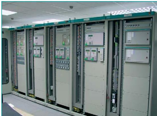
Механичните релейни защити са заменени с микропроцесорно оборудване
